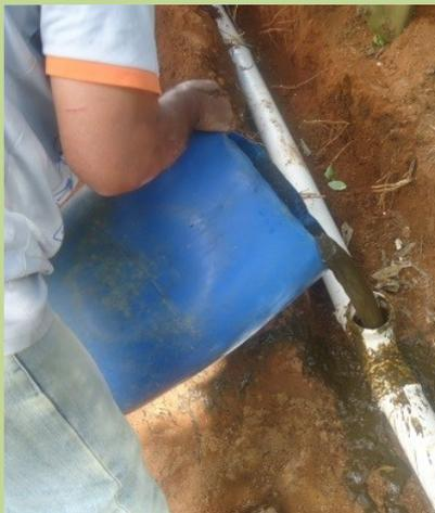
Depois de concluída a montagem da fossa, a primeira caixa deve ser preenchida (através da válvula de retenção) com 20 litros de uma mistura de água e esterco bovino fresco na proporção de 10 litros de água para 5 litros de esterco. Este procedimento tem o objetivo de inocular bactérias do trato intestinal bovino capazes de degradar o esgoto sanitário em condições anaeróbias. O processo deve ser repetido mensalmente para que a quantidade de microrganismos no sistema permaneça constante.
