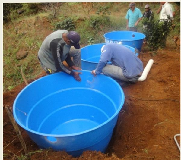
coletora”, é destinada ao armazenamento do efluente já estabilizado, que pode ser retirado para posterior utilização. Como o sistema é modular, o número de caixas aumenta de maneira proporcional ao número de moradores da residência, mantendo-se o volume mínimo de 1000 L para cada caixa.
