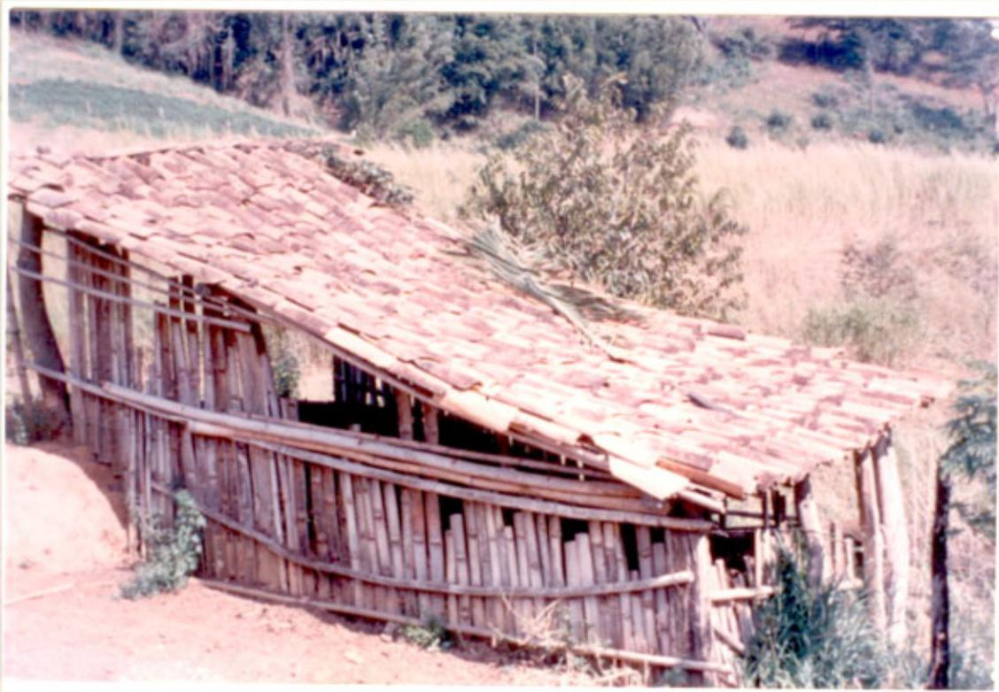
Vista lateral da varanda de esterco, mostrando as paredes de bambu
